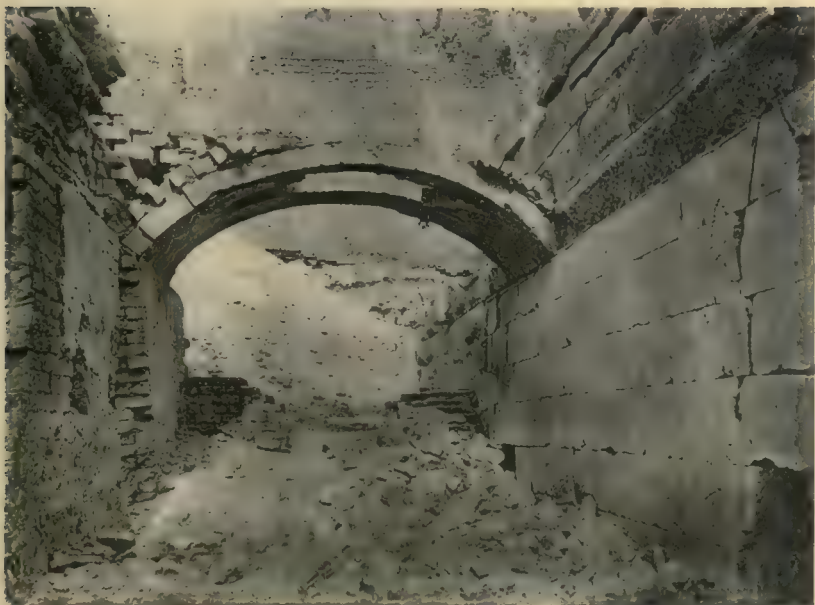
Le couloir copte avant la restauration.
